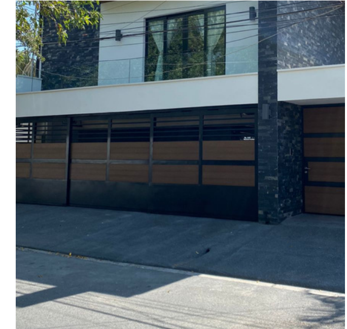
PREPARACIÓN PARA PORTÓN ELÉCTRICO
