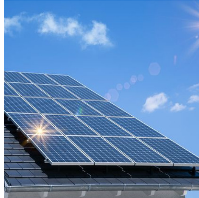
PREPARACIÓN PANELES SOLARES
