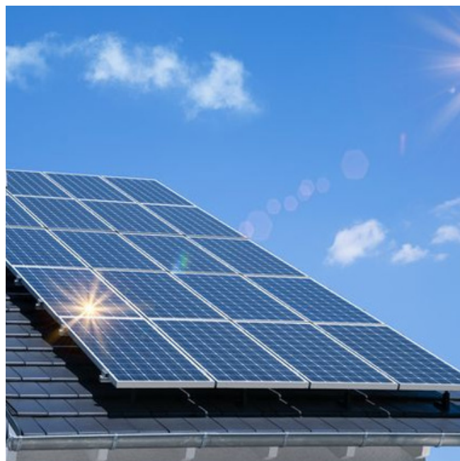
PREPARACIÓN PANELES SOLARES
